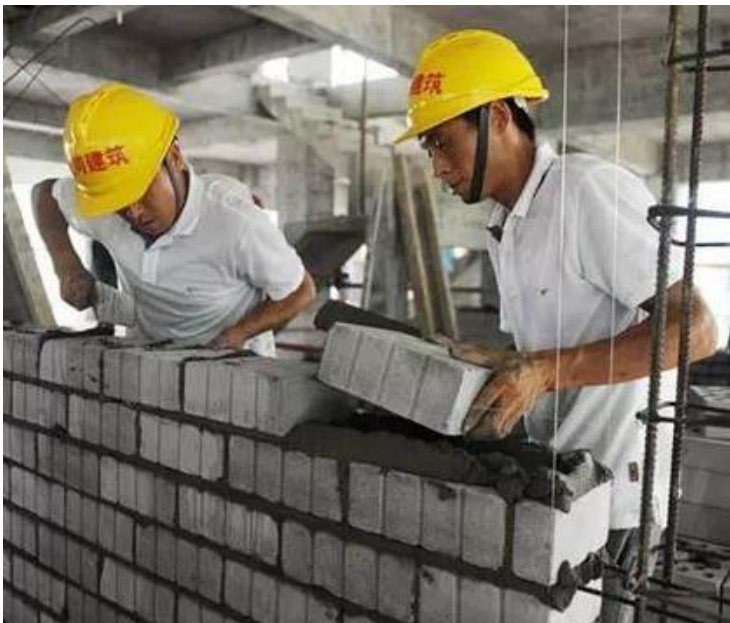
人工现场装配
