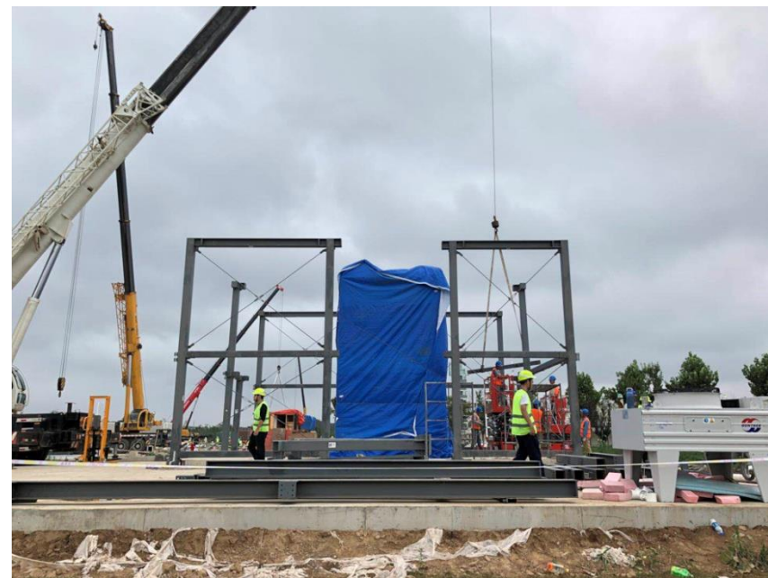
机械化+人工控制拆除再利用
