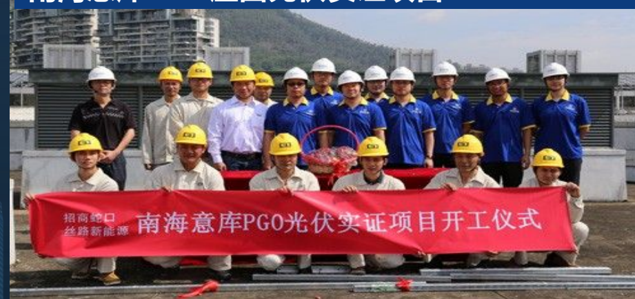
南海意库——屋面光伏实证项目
