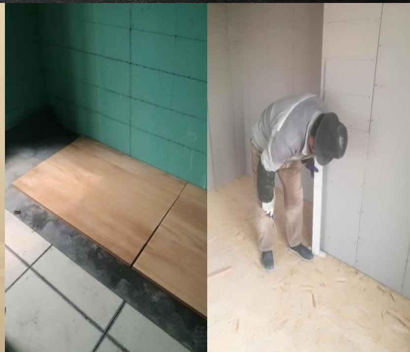
全干法施工架空地面
